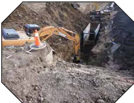
Métis Trail Pipe Install
