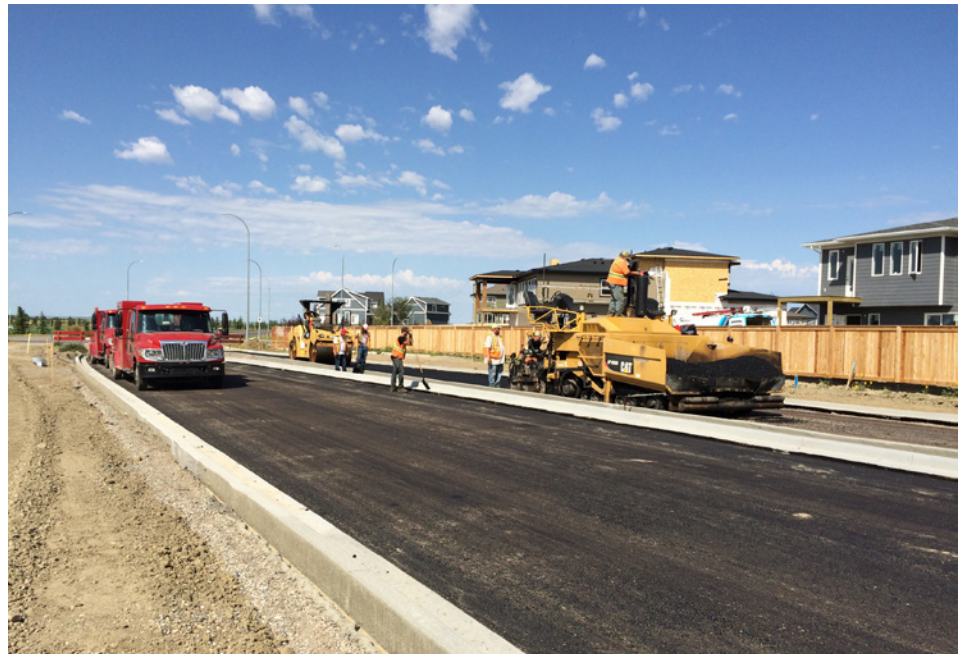
Métis Trail Paving
